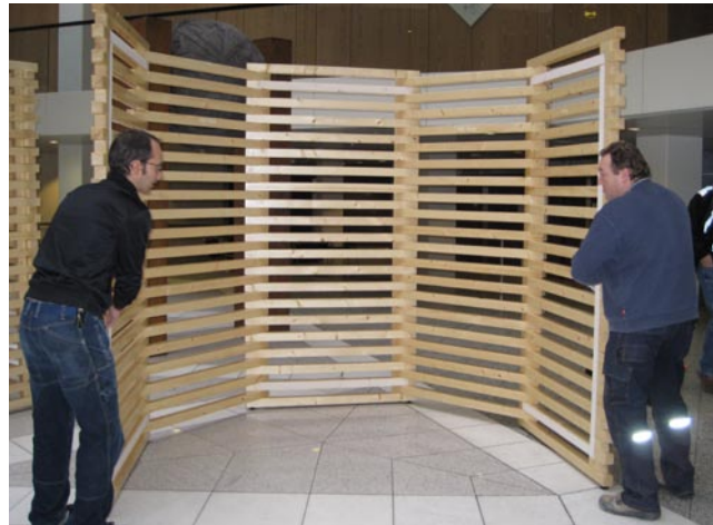
Das Gestell von Modul 1 setzt sich aus drei Teilen zusammen. Die äusseren Schenkel werden nicht parallel zueinander gestellt, sondern um je 10° weiter geöffnet.
