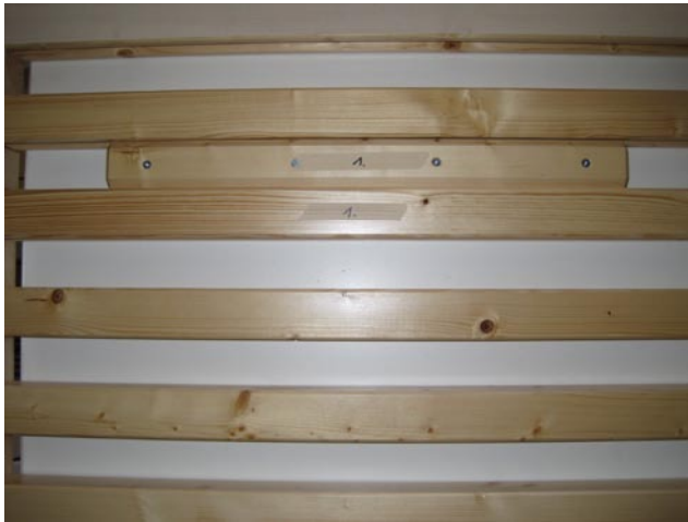
Auf die Rückseite jeder Infotafel sind zwei Kanthölzer geschraubt. Nur das Obere wird mit einem Holzdübel im Gestell verankert.
