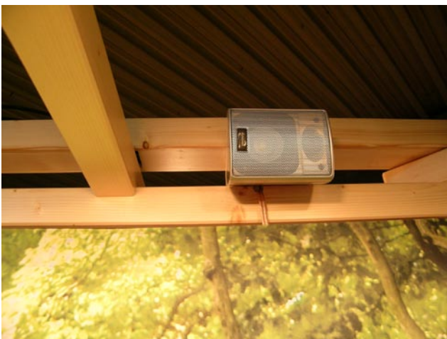
Die Stoffbahn wird mittels Flausch- und Hakenband am Gestell befestigt. Die Kabel von Lautsprechern und Monitorkasten werden dahinter verborgen
