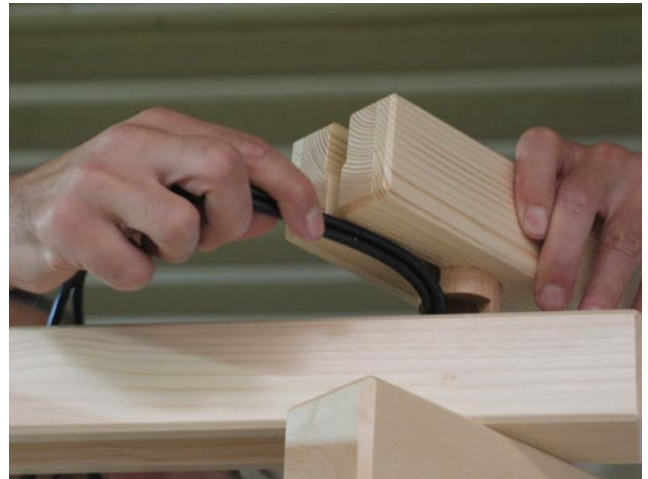
Als nächstes die Strombrücken aufstecken und die Leuchtenkabel verlegen.
