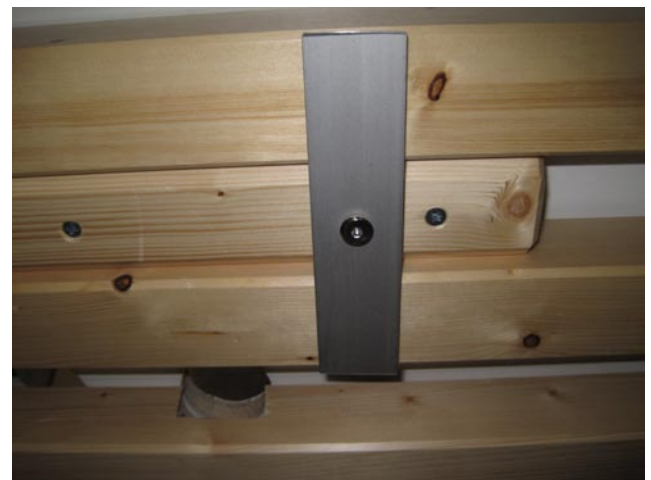
Das Tafelkantholz auf der Rückseite des Waldspielmonitors besitzt eine Zugverriegelung, die vor Befestigung des Monitors ausgeklappt wird.
