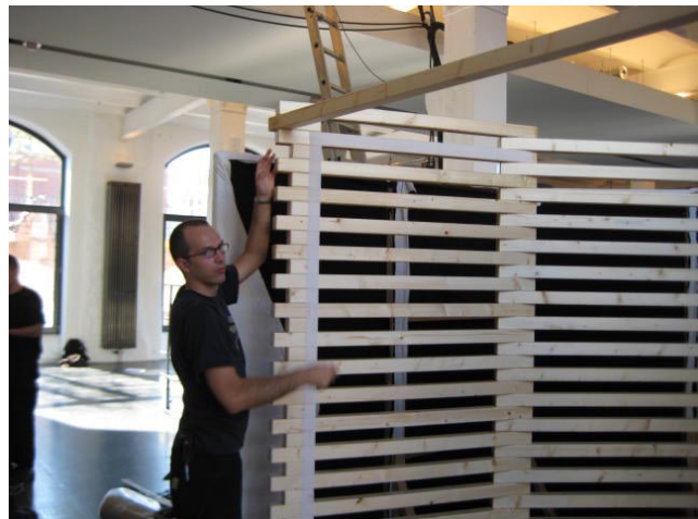
Das Aussteifungskanholz zu zweit auflegen und mit zwei Holzdübeln fixieren.
