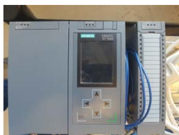
Abbildung 6: Schaltschrank pro Werkbankinsel
