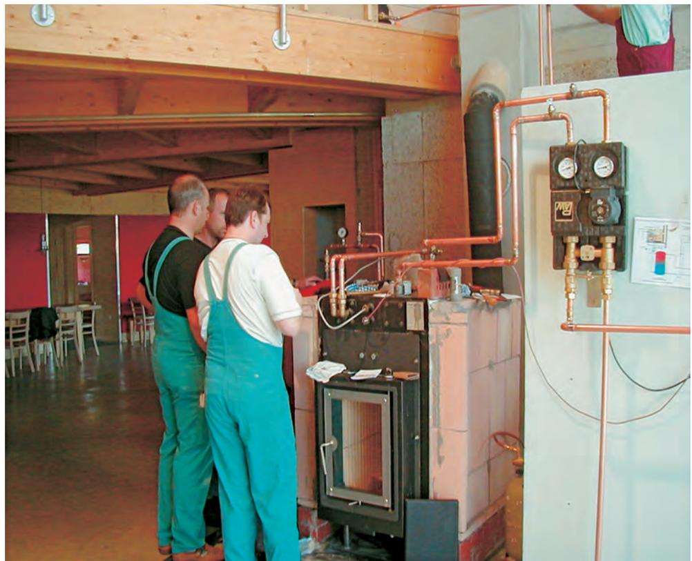
*Heizeinsatz mit Warmwasserwärmetauscher*
