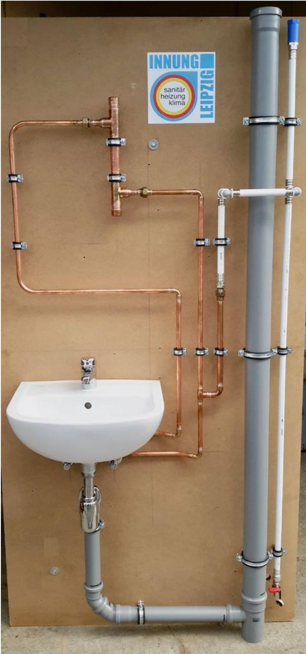
**Abbildung 56:** Ansicht 1 zum Arbeitsergebnis der praktischen Aufgabe im Prüfungsbereich Versorgungstechnik (Quelle: Innung Leipzig)
