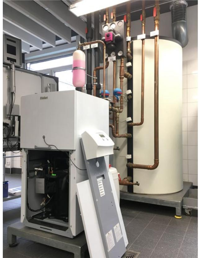
**Abbildung 78:** Systemuntersuchung im Rahmen der Instandhaltung und Inbetriebnahme einer Wärmepumpe, Einsatzgebiet erneuerbare Energien und Umwelttechnik (Quelle: BZD)
