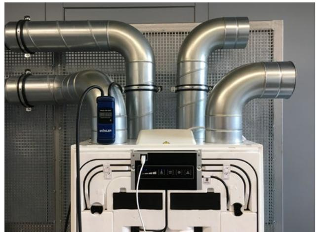
**Abbildung 75:** Differenzdruckmessung im Rahmen der Instandhaltung und Inbetriebnahme eines zentralen Lüftungsgerätes, Einsatzgebiet Lüftungs- und Klimatechnik (Quelle: BZD)
