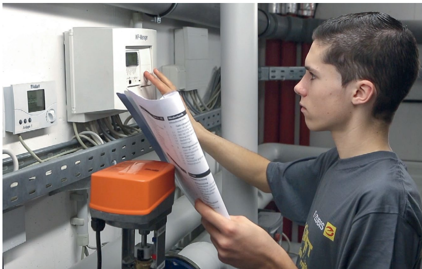
Elektroniker-Auszubildender konfiguriert einen Wärmepumpen-Manager | Foto: Bilderwerk Wiesbaden – Sven Biernath
