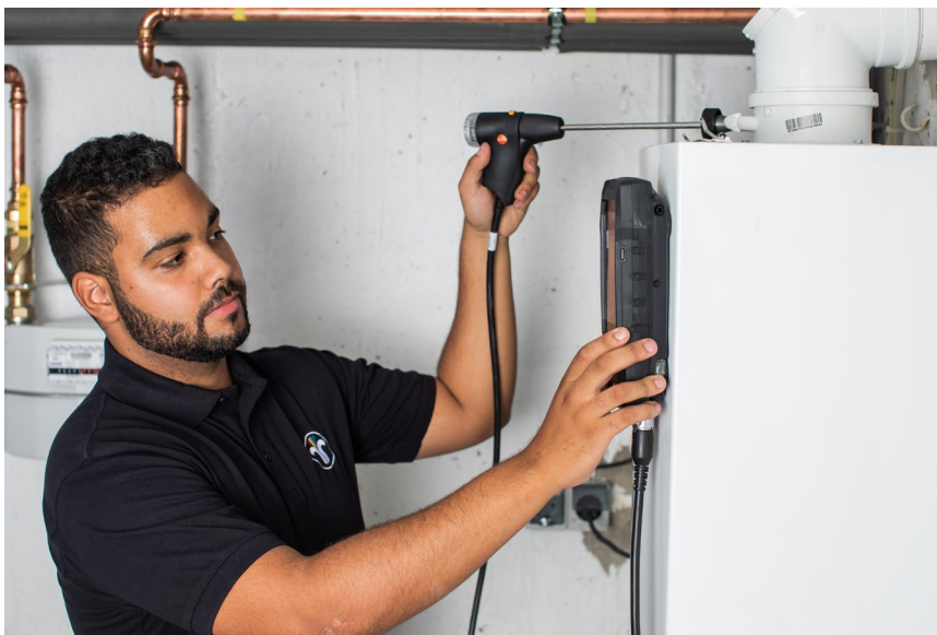
Abgasmessung an einer Heizungsanlage | Foto: Bundesverband des Schornsteinfegerhandwerks
