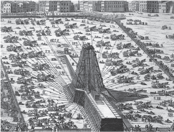
Abbildung 2: Errichtung des Obelisken auf dem Petersplatz in Rom
