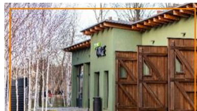
dena@EUREF Nationale Leitstelle Wasserstoff Green Garage
